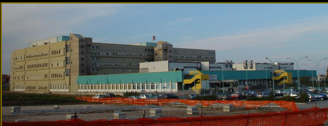
Ospedale San Timoteo, strutture in c.a. 1° e 3° lotto - Termoli (1980)
