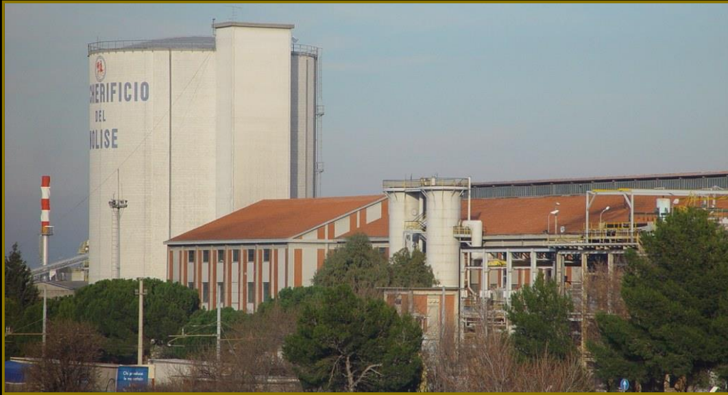
Zuccherificio del Molise, silos - Termoli (1984)
